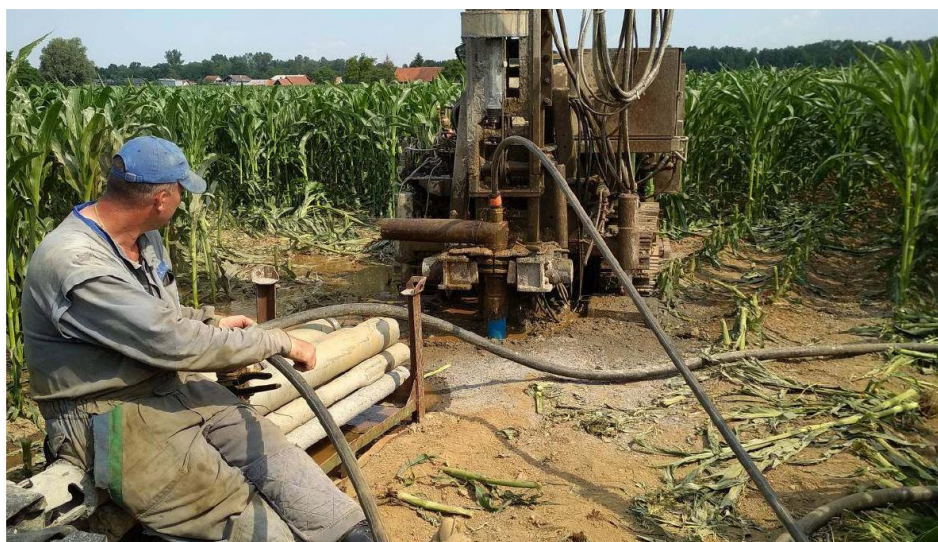
Poskusno polje na Apaškem polju : gradnja opazovalnih vrtin podzemne vode
